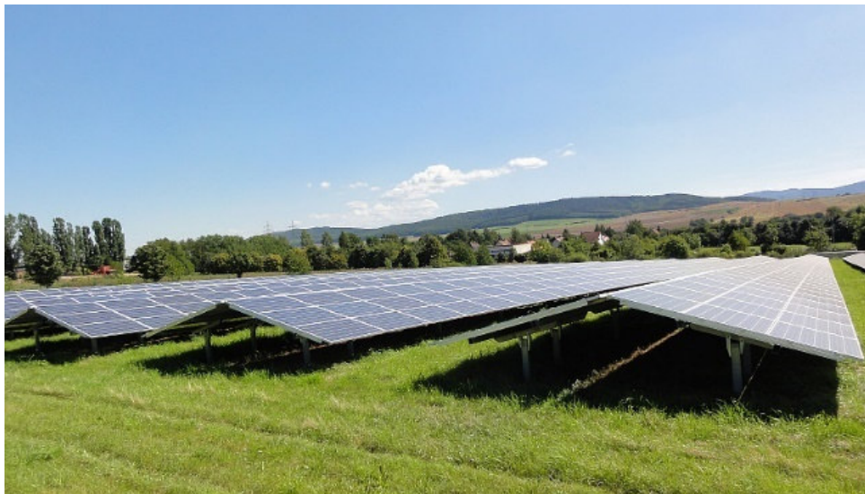
Abbildung 5: Beispiel für eine Freiflächenphotovoltaikanlage (Quelle: www.universal-energy.de )
